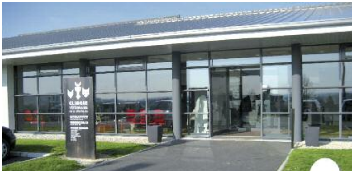
▲ A chaque vétérinaire correspond sa clinique qui répond aux contraintes générales inhérentes à la réglementation mais est aussi adaptée à sa façon de travailler.
